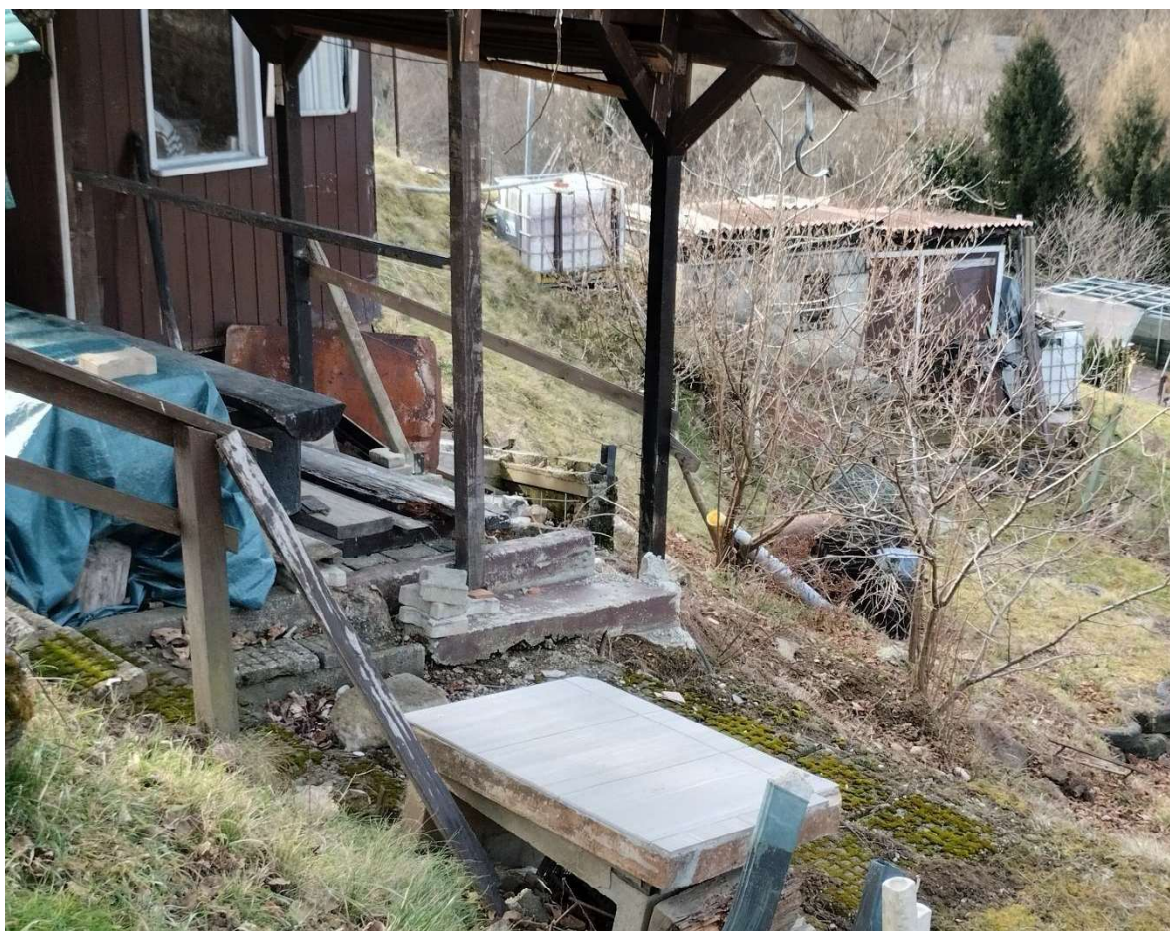
Slika 6: Pogled na razpoke pri vrtni lopi, kjer je viden premik zemeljskih mas
